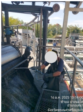
รูปที่ 2-4 การทำความสะอาด Rotary Screen
